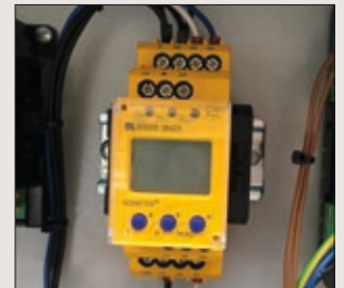
SORVEGLIATORE D'ISOLAMENTO INSULATION SURVEY KIT
